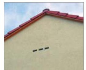
▲ drei Elemente der Fassadenröhre 2FR fassadenbündig eingebaut
