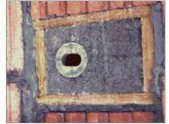
▲ zur Verhinderung von Kältebrücken (Isolierung bauseits)
