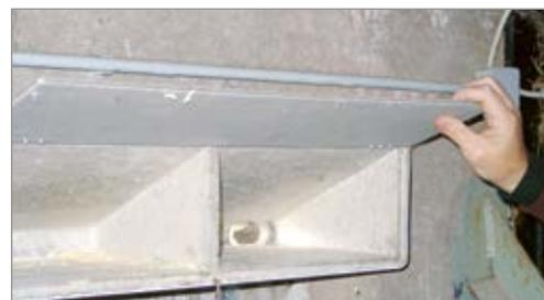
Der Drempeleimer wurde für den Einbau in Dachbereiche (sogenannte Drempeleimer) konstruiert, hat sich aber über die Jahre an vielen weiteren Montageorten bewährt. Er passt exakt in die Belüftungsöffnungen an den ehemaligen Plattenbauten, wie sie in Ostdeutschland sehr verbreitet sind.
