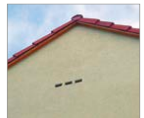
▲ drei Elemente der Fassadenröhre 2FR fassadenbündig eingebaut
