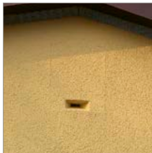
▲ Montagebeispiel unter Putz unter dem Dachfirst
