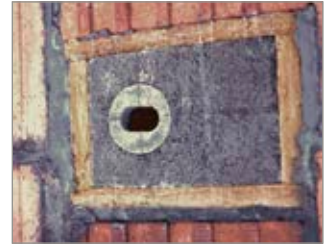
▲ zur Verhinderung von Kältebrücken (Isolierung bauseits)
