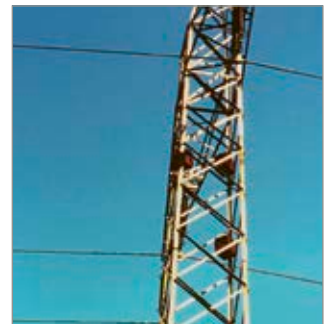
▲ Montagebeispiel an Strommasten
